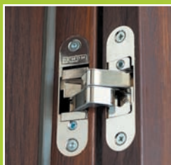
Regulowane trzy zawiasy ukryte (drzwi bezprzylgowe).
